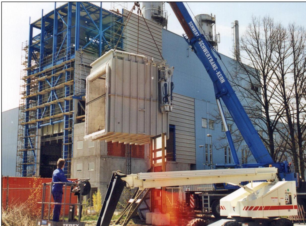
Der Divertor wurde aus Transportgründen mehrteilig ausgeführt und durch das Fachpersonal von RAUMAG-JANICH vor Ort zusammengefügt und in die GUD- Anlage eingebaut. Das Bild zeigt den Divertor mit Innenisolierung und hydraulischem Antrieb. Der Antrieb wird durch zwei Hydraulikzylinder bewirkt. Er ist so angeordnet, dass die Divertor- Welle nur durch relativ geringe Biegemomente beansprucht wird.
